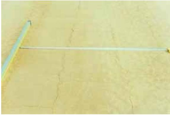
图 15 灰土路基表面干缩裂隙图
