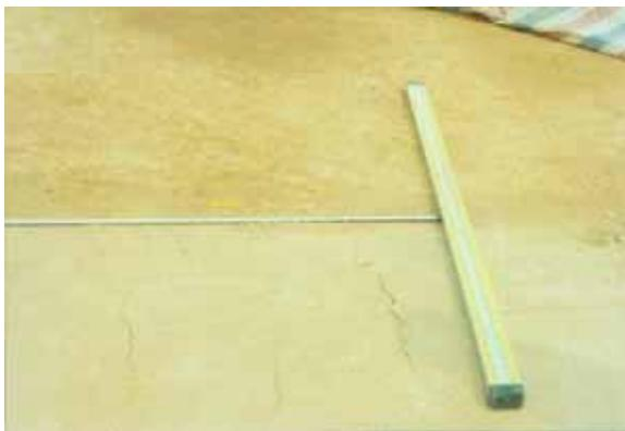
图 16 灰土路基表面有无覆盖效果对比图
