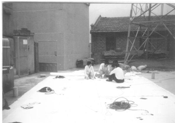
图3 土工膜应变计的安装
