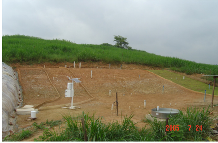
图 1 现场试验边坡 Fig.1 The field test slope
