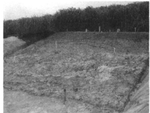
图 17 坡 II 第二次滑坡破坏现象
