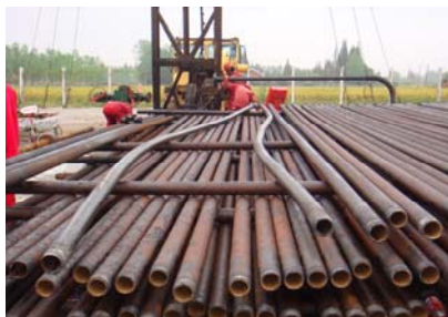
图2 造腔现场提出的 S 型弯曲造腔内管 Fig.2 The crooked inner casing in-situ
