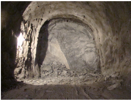
(b) 结构面形成掌子面岩爆爆坑的右侧平直边界
