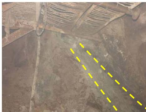
图 9 TSP 探测断层破碎带照片
