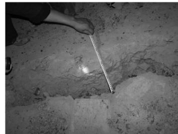
图 4 底板裂缝
