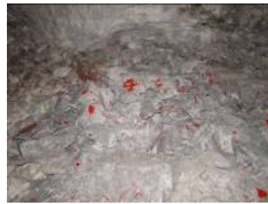
(a) 剥落破坏掉落的岩片
