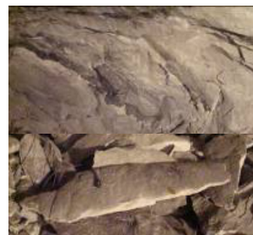
图 6 2#试验支洞中的薄板状破坏
