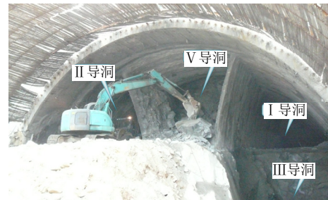
图1 V级围岩段开挖步序图
