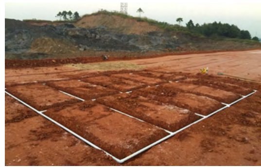
图 3 进排水花管网及现场铺设示意图
