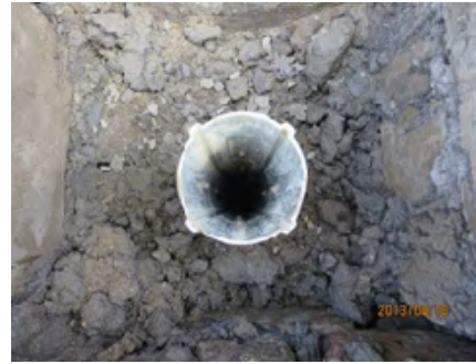
图 3 测斜孔 Fig.3 Inclinometer borehole
