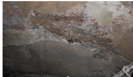
(c) 东主井井筒结构破坏
