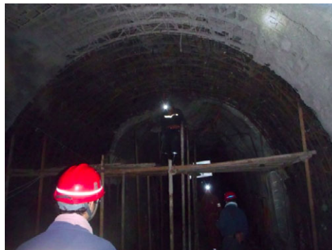
图 13 全封闭格栅钢架支护效果图
