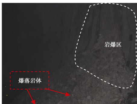
图 2 2011 年 11 月 6 日岩爆现场照片 Fig. 2 The rock-burst on 6 November 2011
