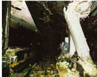
图 1 大开车站中柱弯曲破坏
