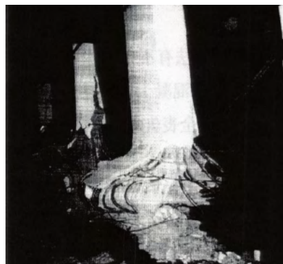
图 3 大开车站中柱弯剪联合破坏
