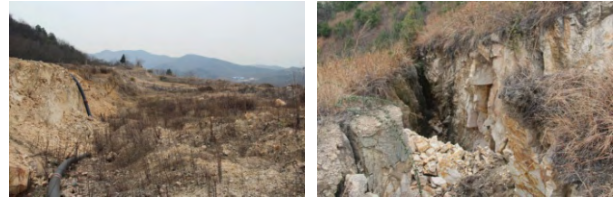
图 13 地表深部裂缝
