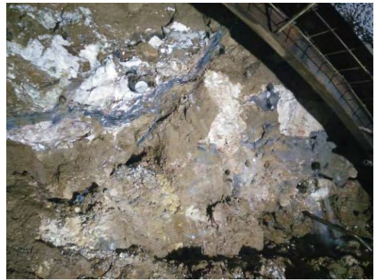
图 10 突水灾害治理后开挖掌子面情况
