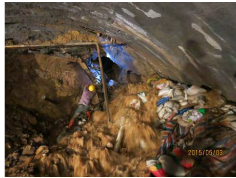
图 4 “5.1 突水”掌子面突水情况
