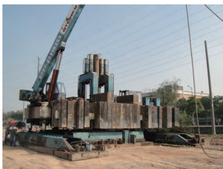
图2 (网络版彩图)ST场地现场压桩照片
