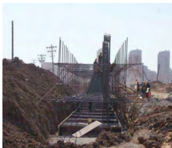
(a) 扶壁式挡土墙现场施工图
