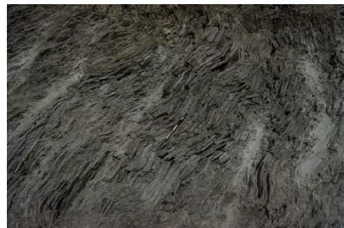
图 15 4 # 导流洞 0+550 m 断面左侧边墙层状岩体层面分布图
