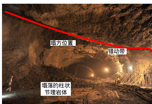
图 9 导流洞内柱状节理与错动带组合破坏模式
