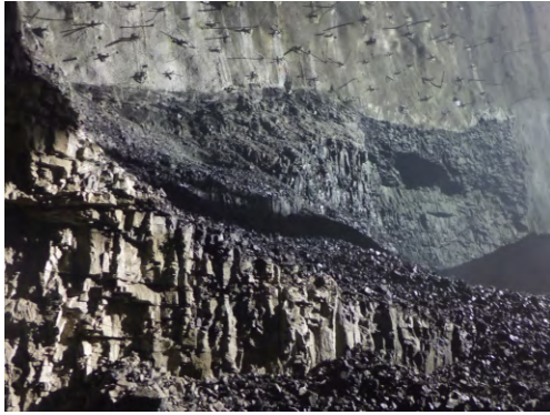
图1 导流洞内柱状节理分布
