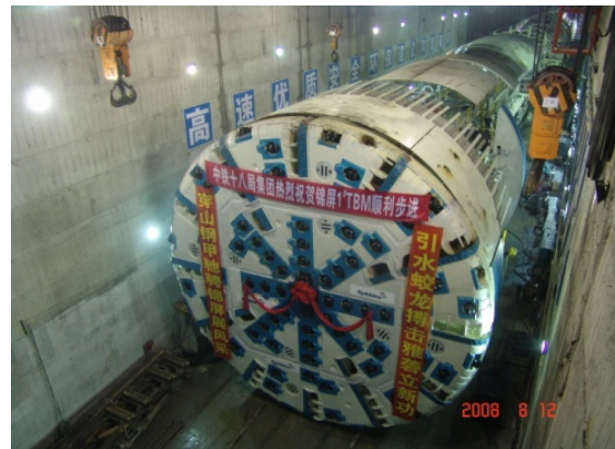
图 1 ROBBINS 410-319 开敞式 TBM
