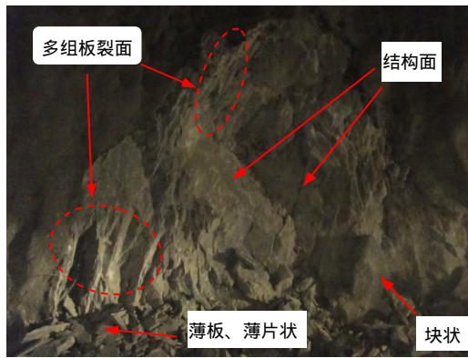
(b) 结构面与隧洞轴线呈大夹角 图 5 岩爆造成隧洞破坏图
