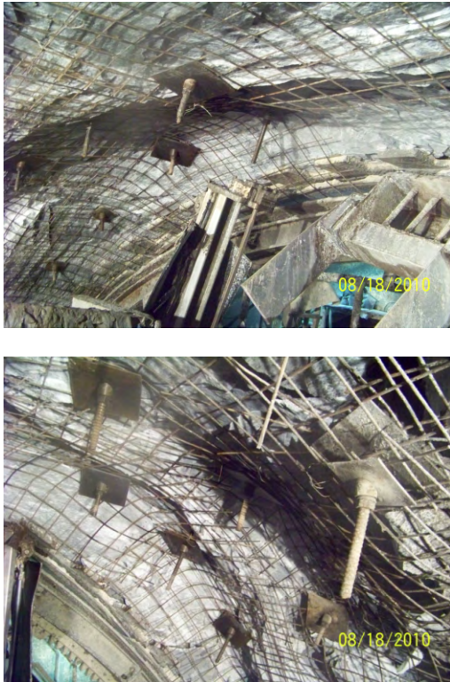
图 3 板裂屈曲岩爆破坏图
