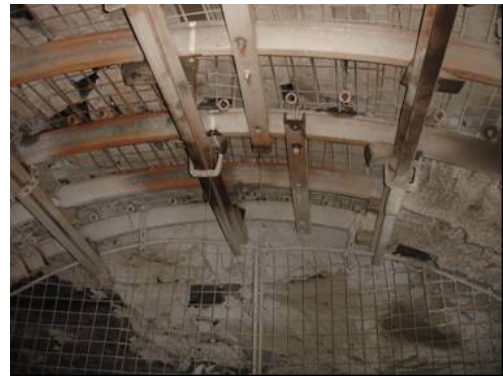
(b) 合理支护方案现场施工
