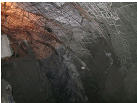
图 14 撑靴对岩壁的破坏
