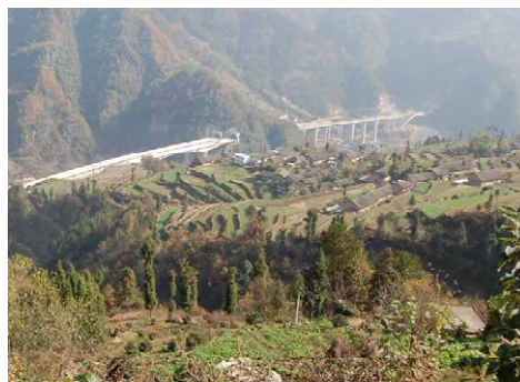
图 13 滑坡全貌图 Fig.13 View of slope slide
