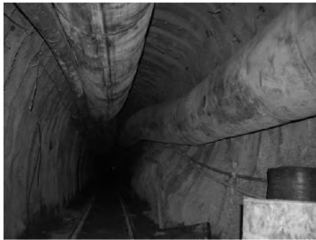
图1 围岩挤压大变形
