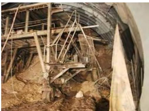
图 2 石林隧道突涌灾害照片
