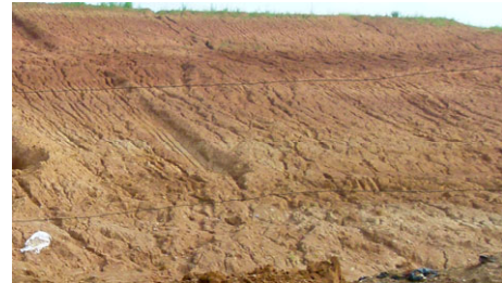
图 1 边坡土体分层照片
