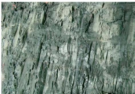
图 1 导流洞内柱状节理分布
