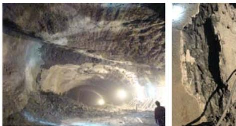
图 2 隧洞内柱状节理垮塌情况
