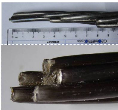
(a) 现场锚索钢绞线的断裂端部特征
