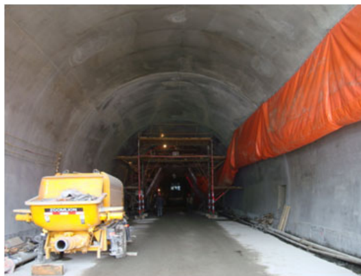
图 14 二衬模筑混凝土施工现场效果
