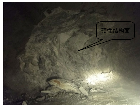
图 8 岩爆案例 2 的爆坑图 Fig.8 Pit figure in case 2 of rockburst
