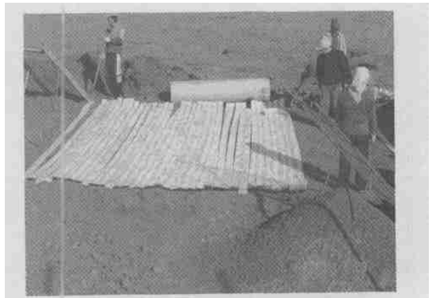
图4 塑料排水板铺设现场
