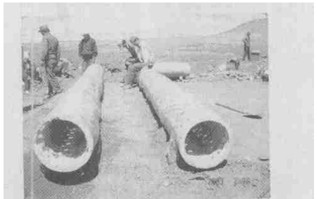
图5 试验路基通风管埋设照片
