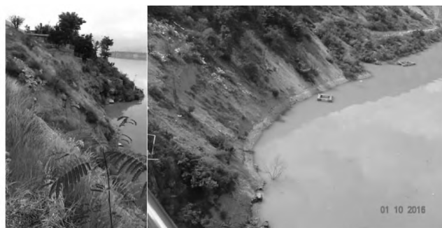
图3 塌岸问题 Fig.3 Bank collapse
