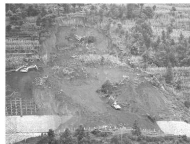
图 6 高速公路沿线某滑坡现场
