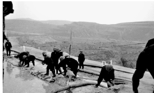
(a) 漫顶事故处理
