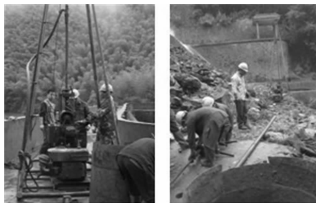
图 3 富家坞尾矿初期坝现场勘察
