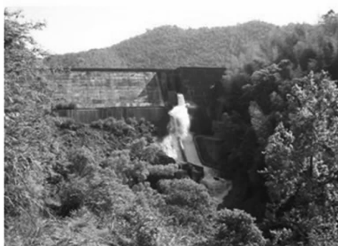
图 1 富家坞尾矿初期坝坝体
