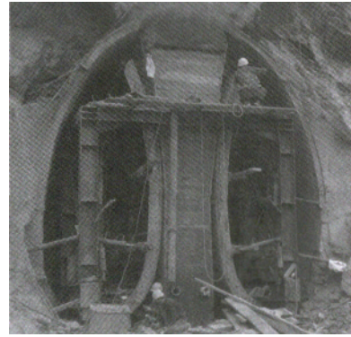
图 4 中隔墙浇筑成型
