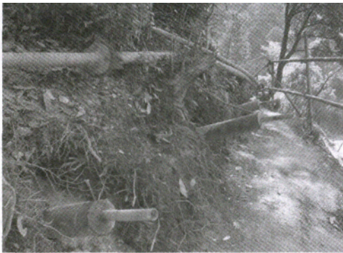
图 3 山坡注浆管加固
