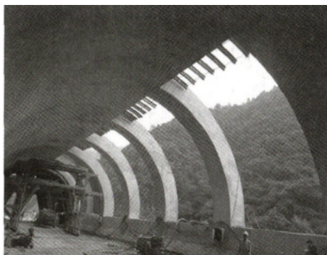
图5 外洞肋梁及防撞墙
