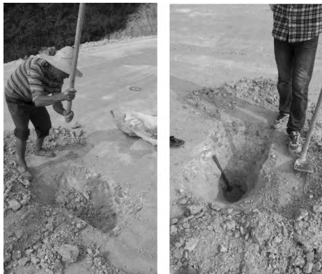
图 13 碾压后刨挖路基
