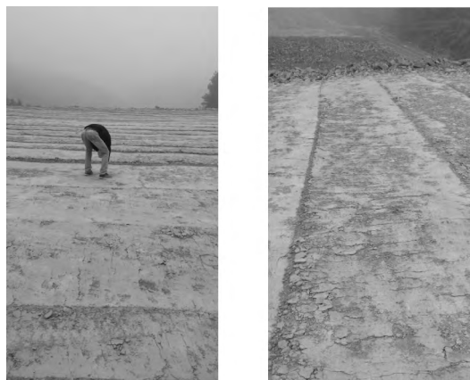
图 16 32 t 压路机碾压后表层粉化
