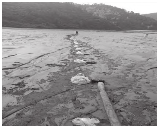
图 1 尾矿坝干滩面尾矿现场取样
